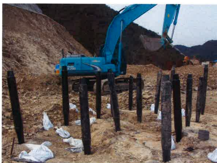
岩盤掘削工法 ユニット破碎工法(特許)
