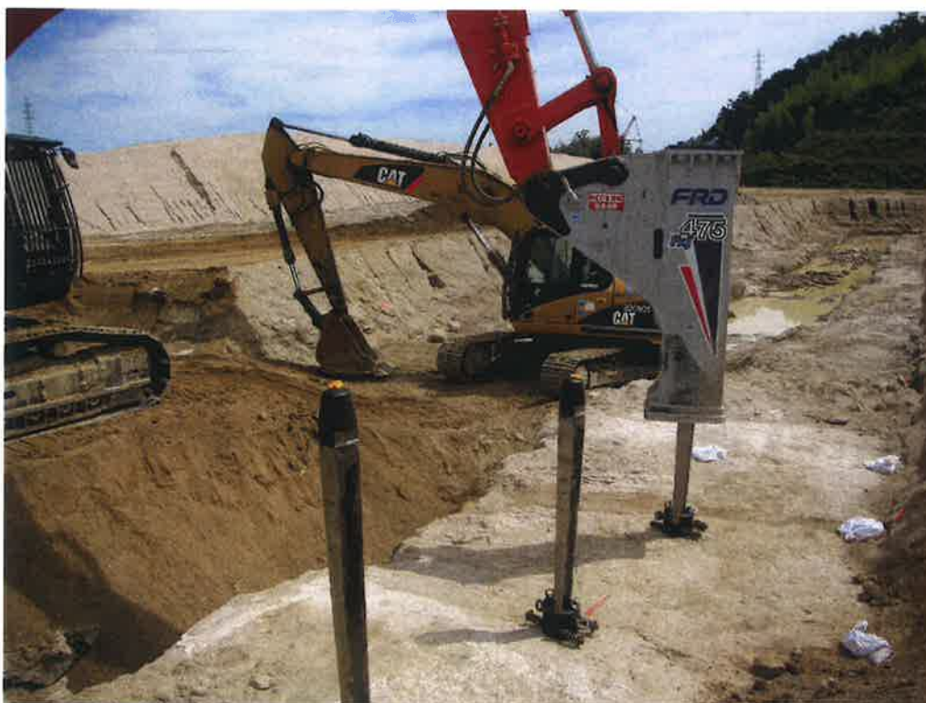
岩盤掘削工法 スーパーかち割り君工法(特許)
