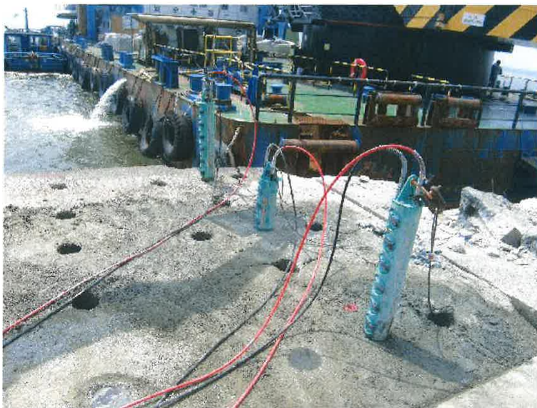
岩盤掘削工法
