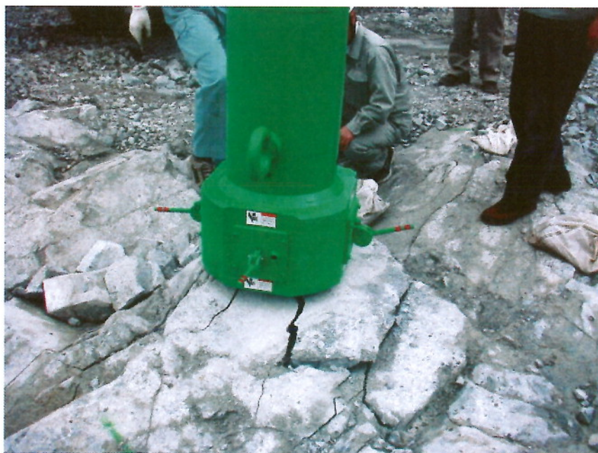
環境に優しい岩盤掘削工法 クォーターセリ矢(特許)
