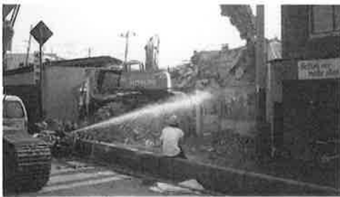
倒壊し解体中の本社ビル
