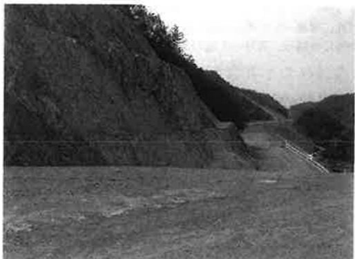
写真—8 法面仕上がり状況 (A 工法)
