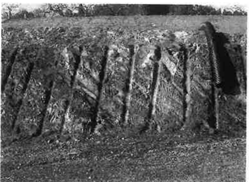
写真—9 法面仕上がり状況 (B 工法)
