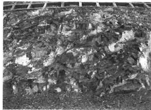
写真—1 従来工法による法面整形の仕上がり状況
