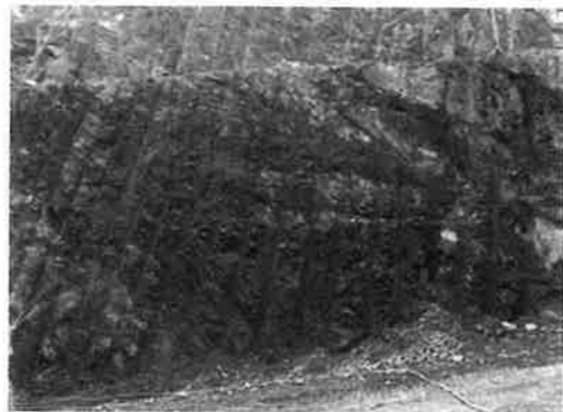
写真—7 法面仕上がり状況 (B 工法)
