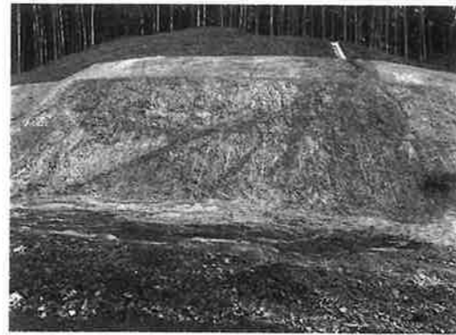
写真—6 法面仕上がり状況 (A 工法)
