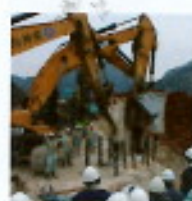
くさび式岩盤破碎NO.1ト30
