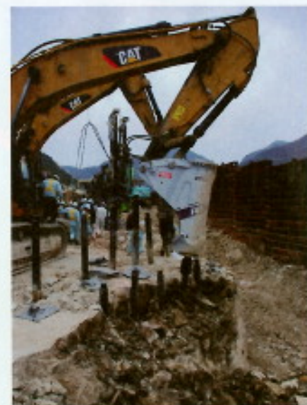
「かち割り君」を使用後、油圧ショベルで簡単に岩を撤去できる。細分化などの二次破碎が必要ない
