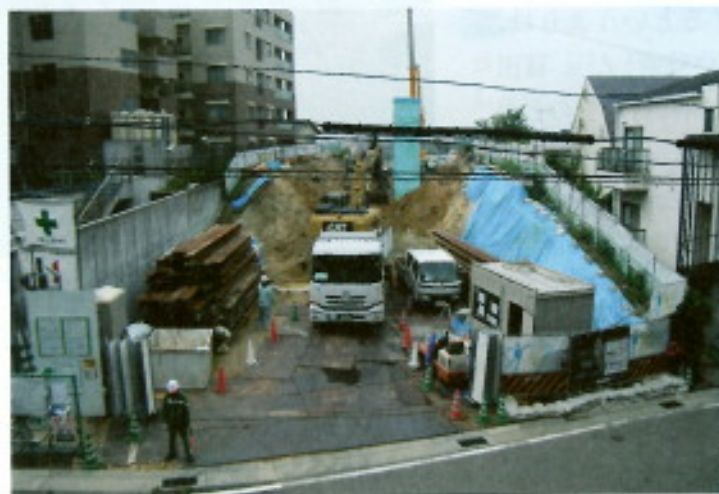
11年に完了した兵庫県西宮市甲陽園でのマンション基礎岩盤掘削工事の様子。近隣にマンションが立ち並ぶなか、「クォーターセリ失」で岩盤を破碎して、苦情なく工事を終えた(写真:神島組)
