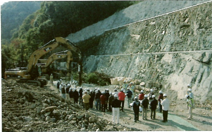
09年11月に開催した地域住民向けの見学会。38人が参加した。工事概要を説明したほか、クォーターセリ矢の施工や破碎後の岩盤をリッパで引き起こす様子を実演
