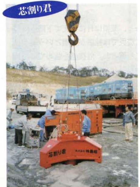
地面に水平に広がった岩盤をしんから割り抜いて除去しやすくする「芯割り君」
