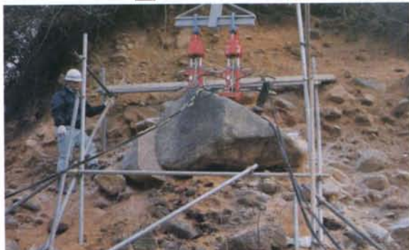
「ツレール君」の仕組みと、道路などの法面に露出した岩を除去する作業のイメージ図(上)。左は実際に岩を除去する作業風景
