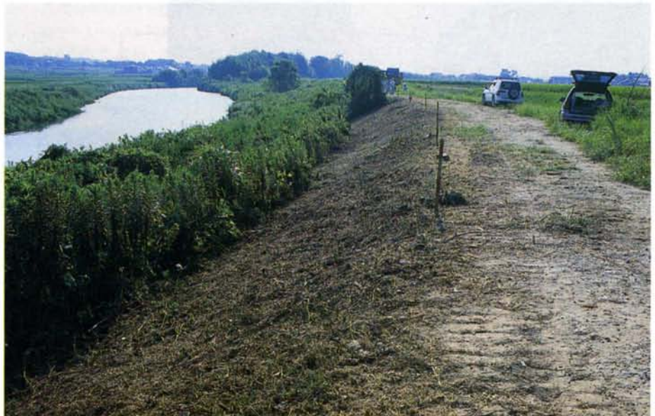
東条川にある堤防の法面の上部を草かり君で除草した部分
