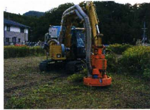
草かり君施工状況
