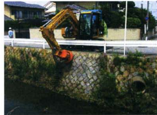
コンクリートブロック積み面での施工
