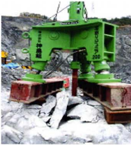
写真 - 7 「芯割ジュニア」環境に優しい岩盤掘削工法 文部科学大臣表彰科学技術賞受賞 発明大賞持田発明功労賞受賞
