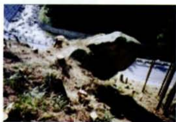
写真 - 3 法面岩石撤去工（着工前）
