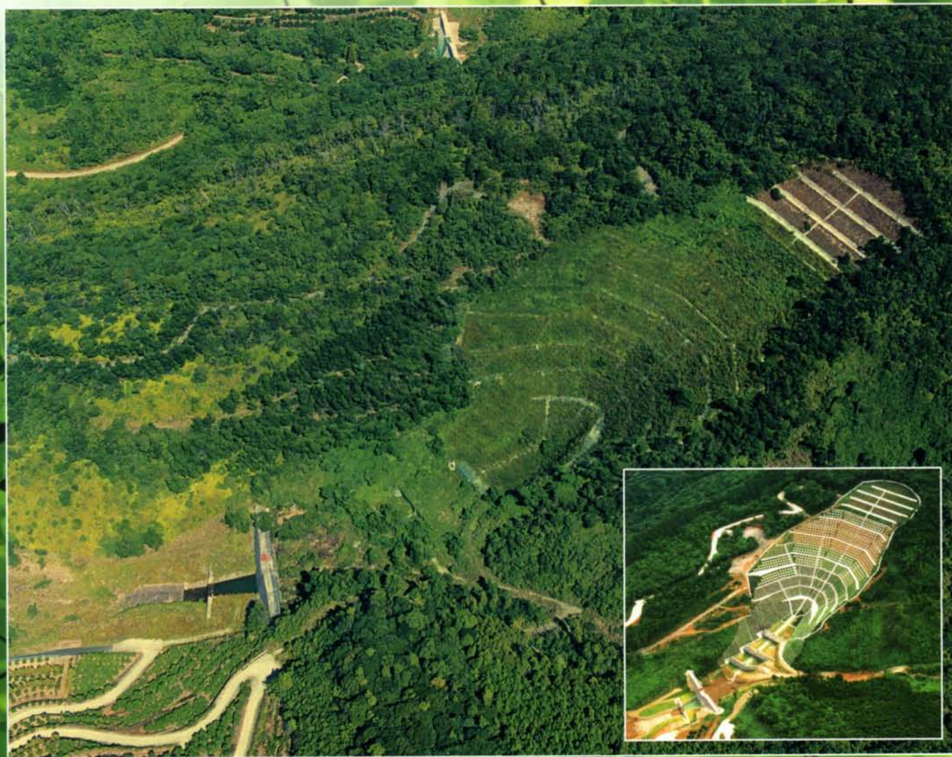
鹿児島県出水市堺町針原地区（斜面安定と緑化の実現） KTB永久アンカー工法・PCフレーム工法・緑化工
