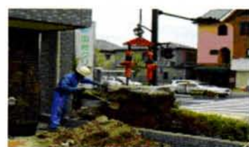
写真 - 5 市街地での活用例（看板基礎吊出）
