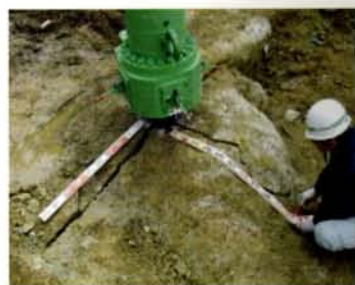
写真-10 クォーターセリ矢による破碎状況
