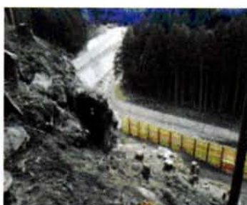
写真 - 4 岩石撤去工（竣工）
