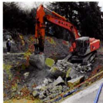
写真-12 岩盤の引き起こし
