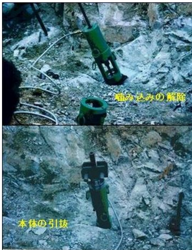
カチットアンカーの引抜
