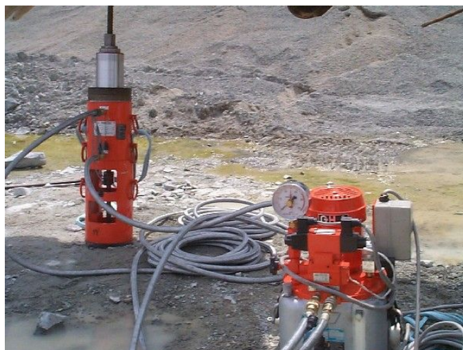
カチットアンカー限界実験
