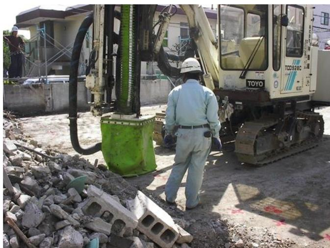
削孔時におけるクローラードリルの騒音・粉塵対策
