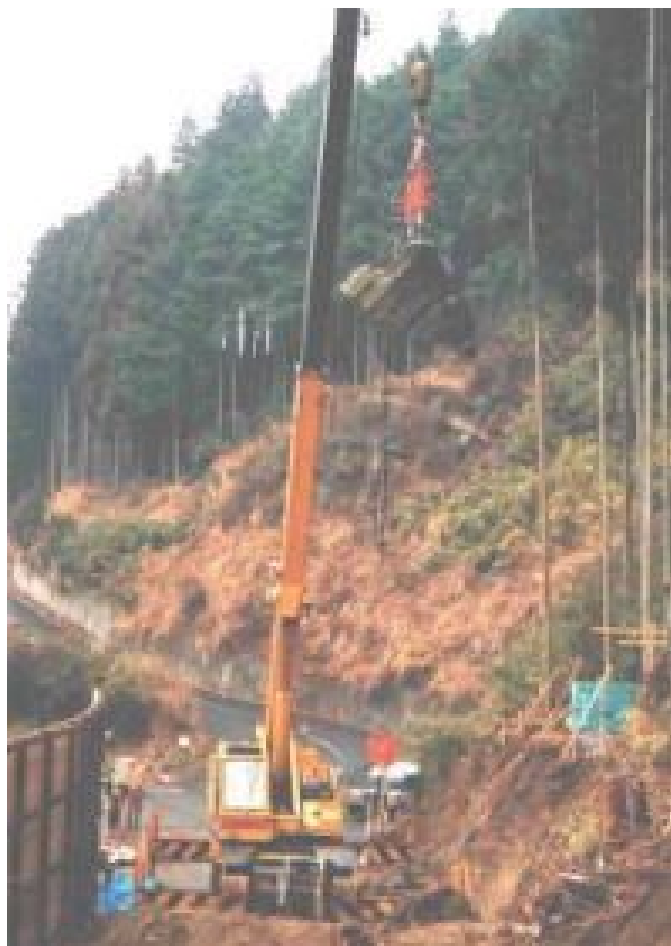
吊り出し完了
