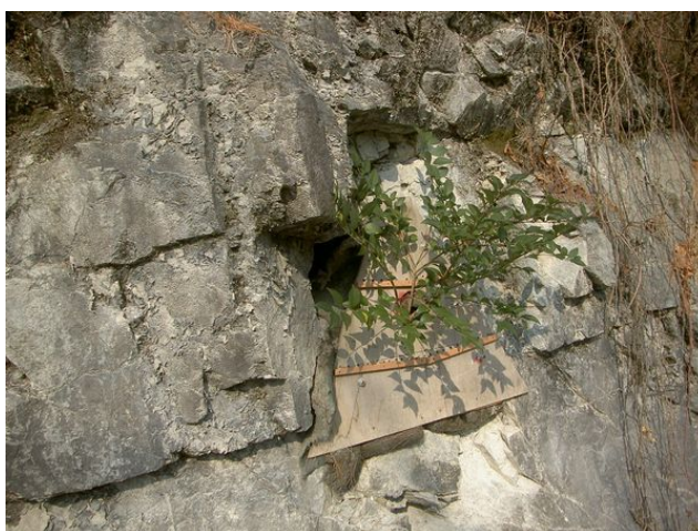
「木竹君」設置完了
