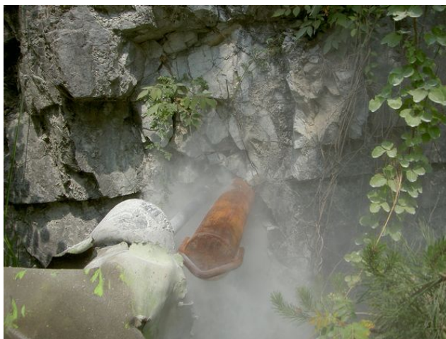
植穴削孔状況
