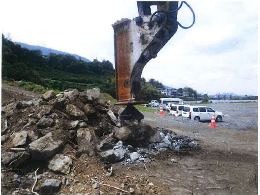
施工方法写真 タイトル 小割用特殊装置「パカット君工法」による破碎(小割)状況
