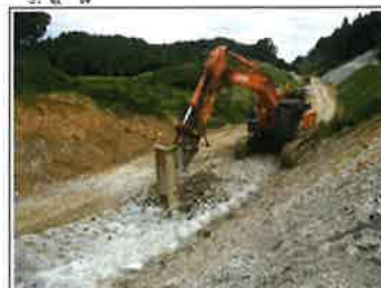
特殊芯入楔型チゼル バックホウ山積1.9m 3 日立建機 ZAXIS 470 超低騒音型大型ブレーカ 古河ロックドリル Fxj475ss 特殊芯入楔型チゼル
