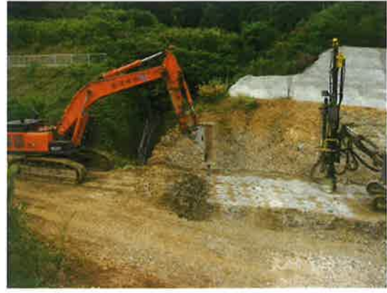
かち割る君工法 作業状況
