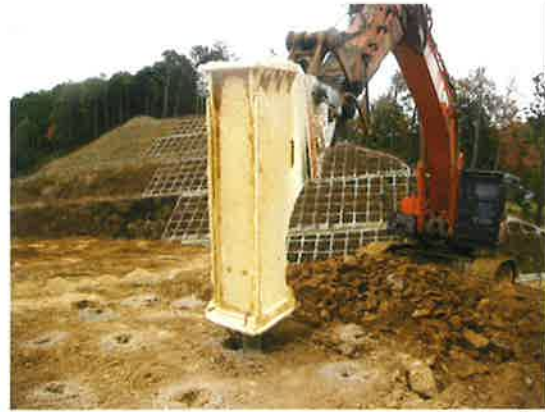
「かち割る君工法」岩盤破碎状況
