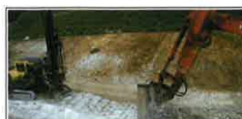
超低騒音型大型ブレーカ 古河ロックドリル Fxj475ss バックホウ山積1.9m 3 日立建機 ZAXIS 470
