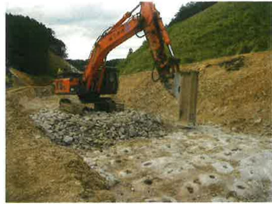
かち割る君工法 中硬岩破碎
