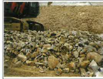
かち割る君工法 実証実験状況
