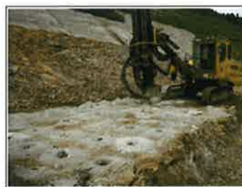
削孔状況 低騒音型クローラドリル エピロック T45
