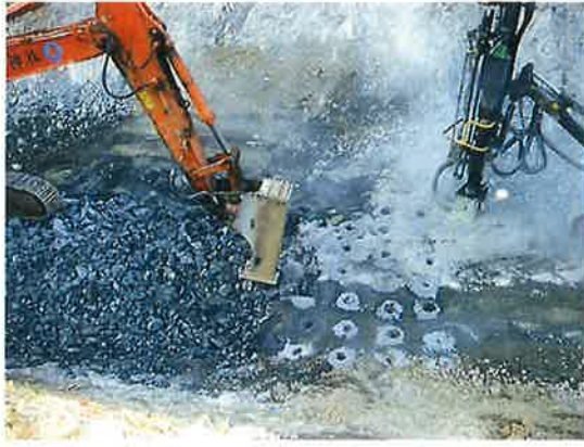
かち割る君工法 小割状況
