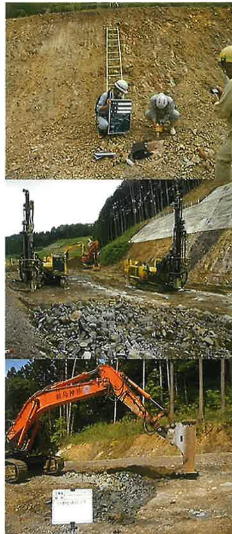
かち割る君工法作業状況(岩判定～削孔～破碎)
