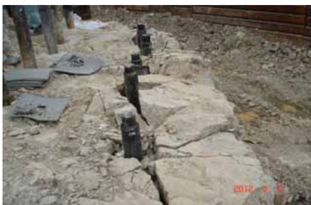
(写真-6 特殊楔式チゼルのユニット破碎工法)
