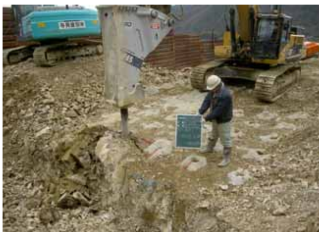
(写真-3 割岩状況)
