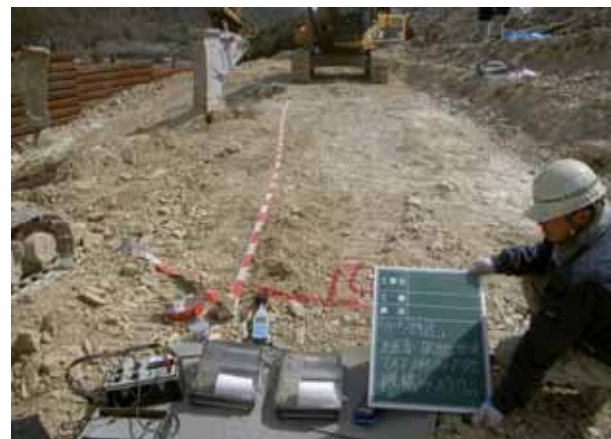
(写真-3 施工時の振動・騒音測定状況10m地点)
