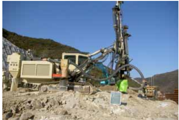
(写真-2 施工時の削孔状況)
