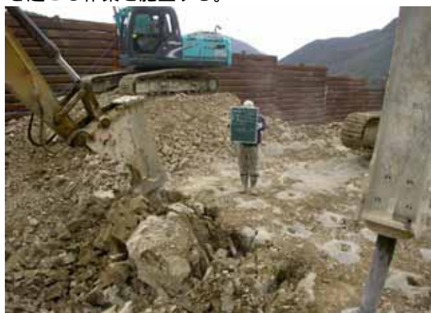
(写真-5 引き起こし状況)
