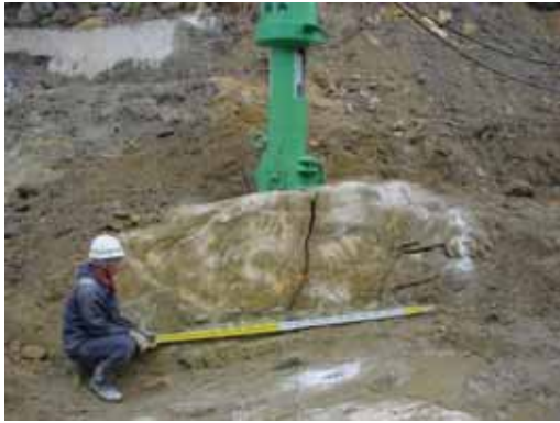
写真 - 4 破碎後の状況
