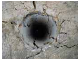
写真 - 6 当機械による破碎後の削孔口を上から見た状況です。
