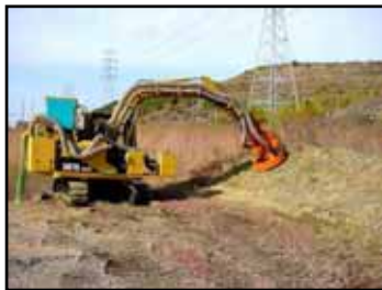
「法面での除草」
