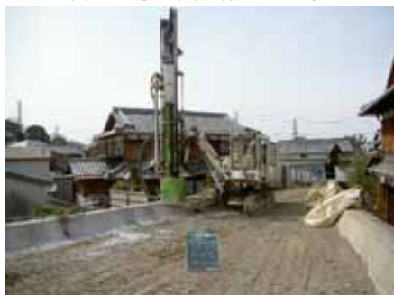
写真-4 家屋隣接部の施工状況
