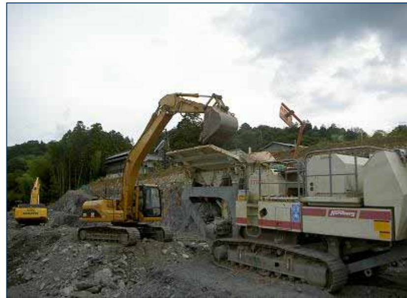
発生岩のリサイクルによる再利用
