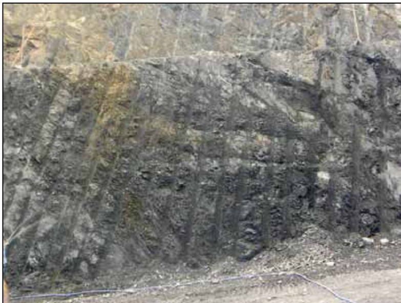
法面景観工法完了
