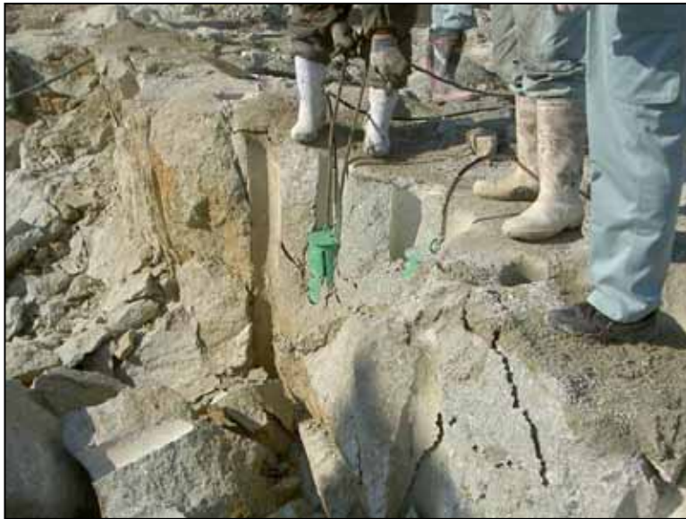
岩盤法面整形装置を挿入
