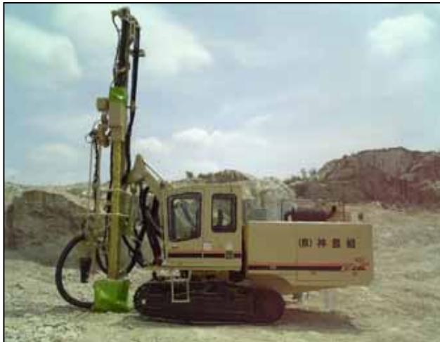
カ-ラドリル又はコンク リートコアボーリング
