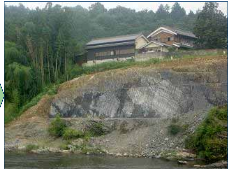
民家真下での施工完了
