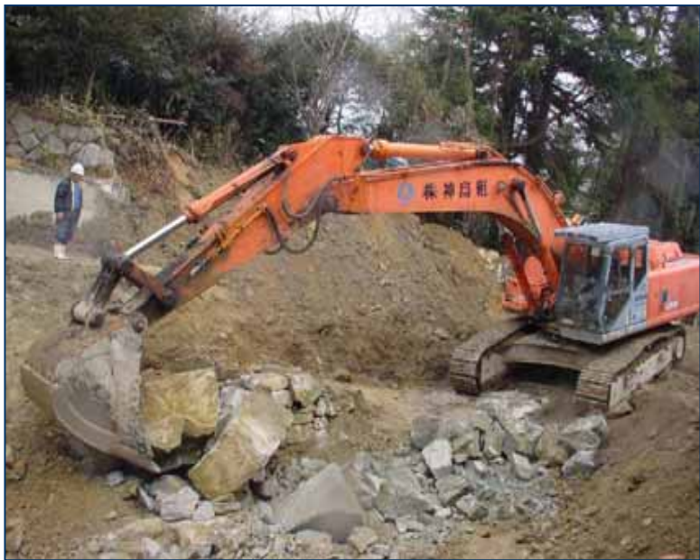
積み込み処分
