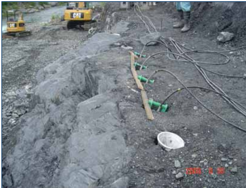
岩盤法面形成装置を挿入
