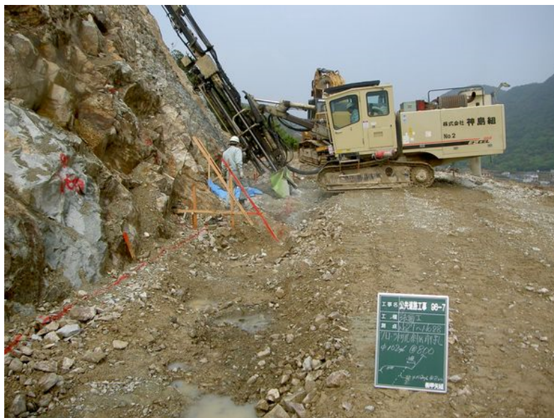
クローラドリルによる斜め削孔
