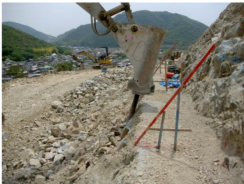
「かち割り君セパレート」法面整形状況
