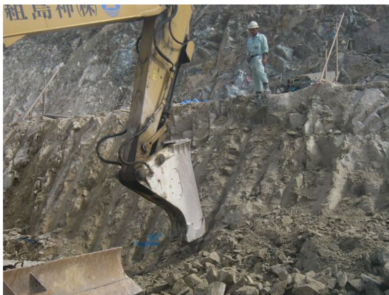
「かち割り君セパレート」岩盤法面整形状況
