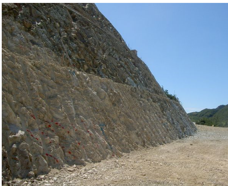
「かち割り君セパレート」工法整形完了
