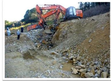
2次破碎状況 破碎岩撤去状況
