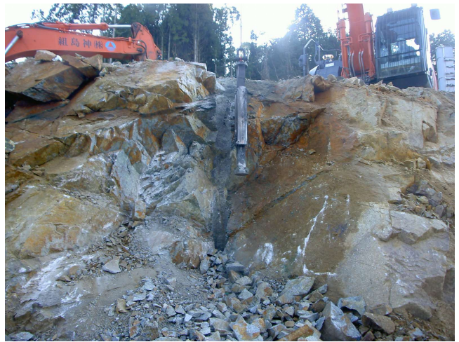
ダルマ落とし工法そこぬき君 破碎完了
