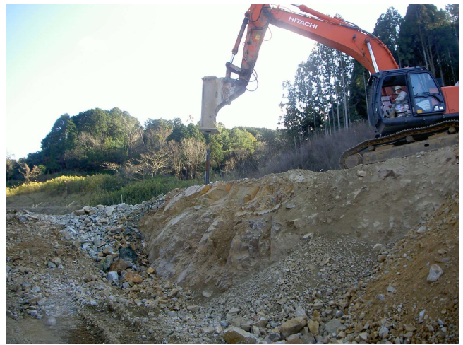
ダルマ落とし工法そこぬき君 破碎作業中
