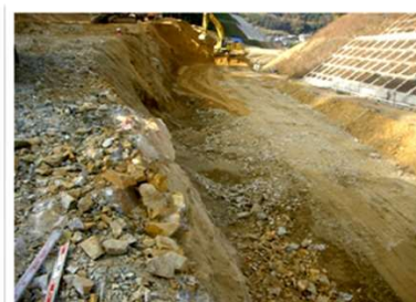
1.実証実験箇所及び岩判定 写真(実験箇所全景)
