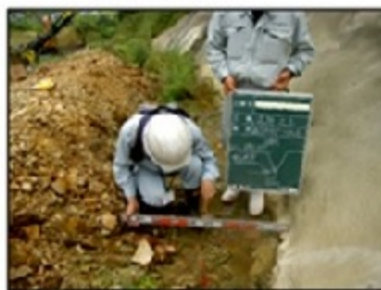
施工立会状況
