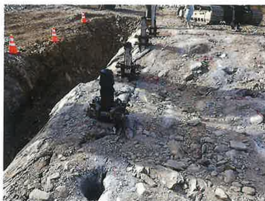
「スーパーくさび君」工法 破碎完了（特殊くさび式割岩装置（Wボルト仕様）打込完了）
