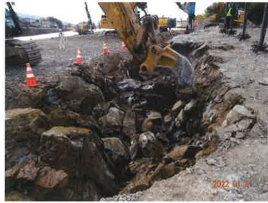
「スーパーくさび君」工法 破碎・リップ引起し状況
