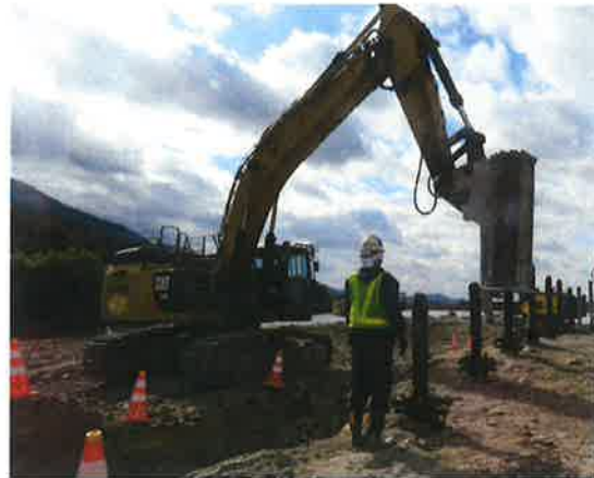
「スーパーくさび君」工法 破碎状況
