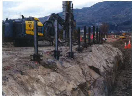
「スーパーくさび君」特殊くさび式割岩装置(Wボルト仕様) 建込完了
