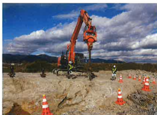
「特殊くさび式割岩装置（Wボルト仕様）」パイプロ引抜状況
