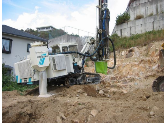
住宅近接での作業状況
