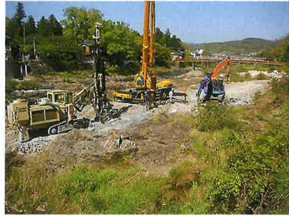
削孔・破砕・引起し
