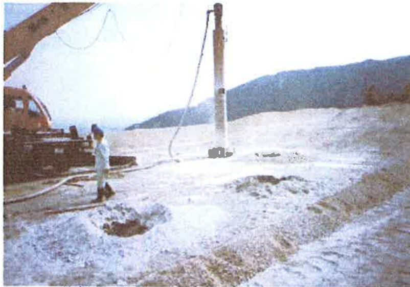
芯割り君を挿入するために、直径600を削孔
