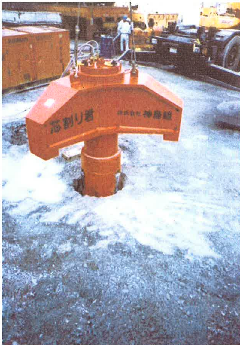
直径600の削孔した中に、芯割り君をセット
