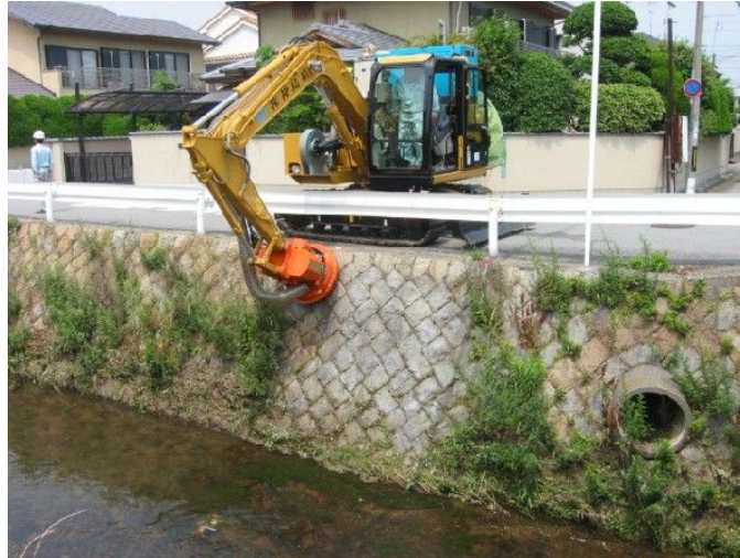
石積除草・研磨のデモンストレーション
