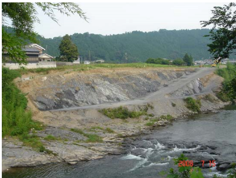
岩盤地肌面をスリット模様仕上げた近隣施工全景写真
