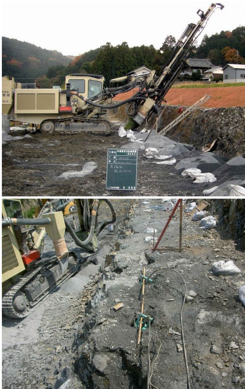
削孔及び破碎状況
