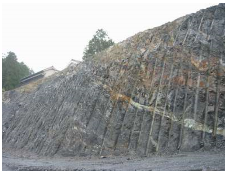
スリット状に整形された岩盤法面
