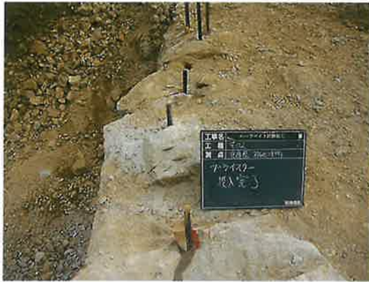
「半割り鋼材」挿入状況
