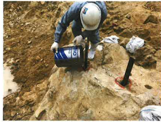
静的破砕剤充填状況
