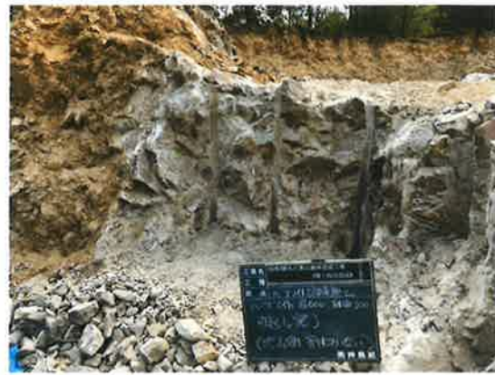
破碎・引きし完了
