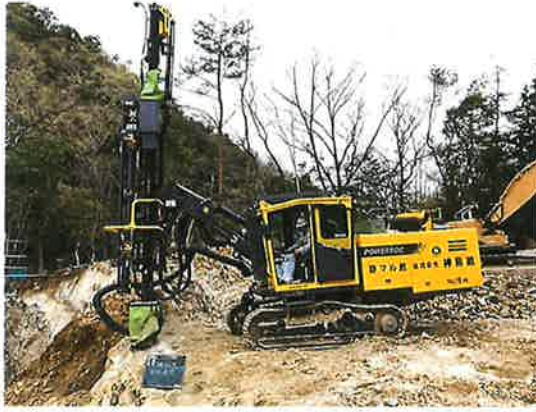
クローラドリル削孔状況
