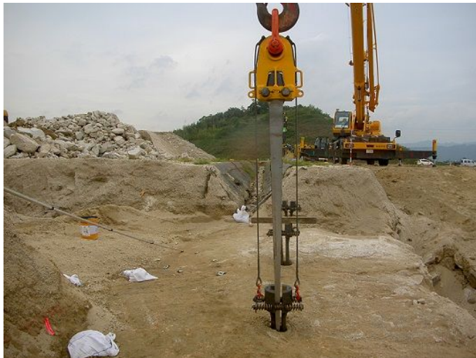
専用吊金具(特殊セリ矢式割岩装置専用)
