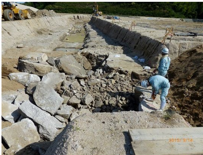
破碎,引起し完了
