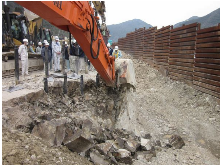
破碎岩引起し
