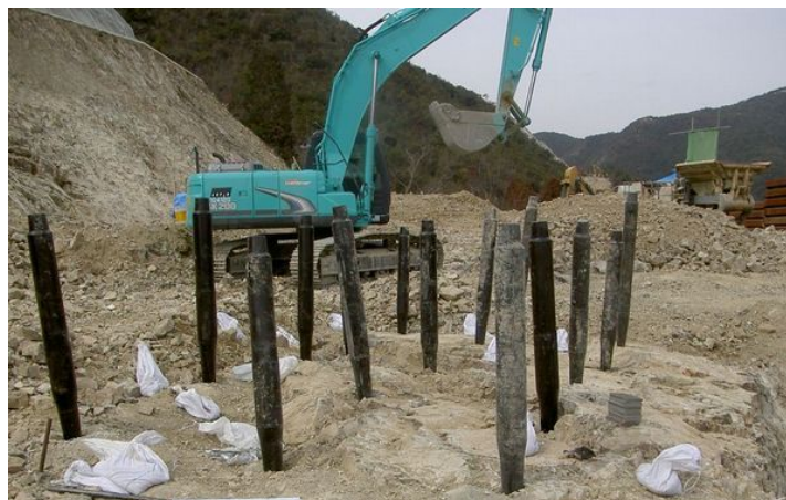
「ユニット破碎工法」建込完了
